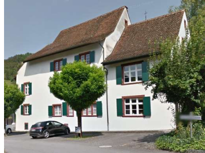
Pfarrhaus – Westansicht (alte Landstrasse 23)
